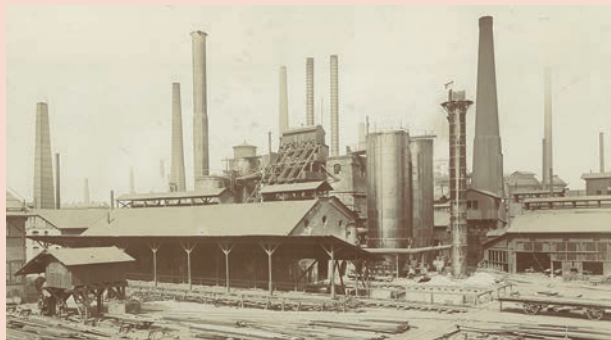
Vysoká pec s Witwelovým ohříváčem větru po roce 1878
